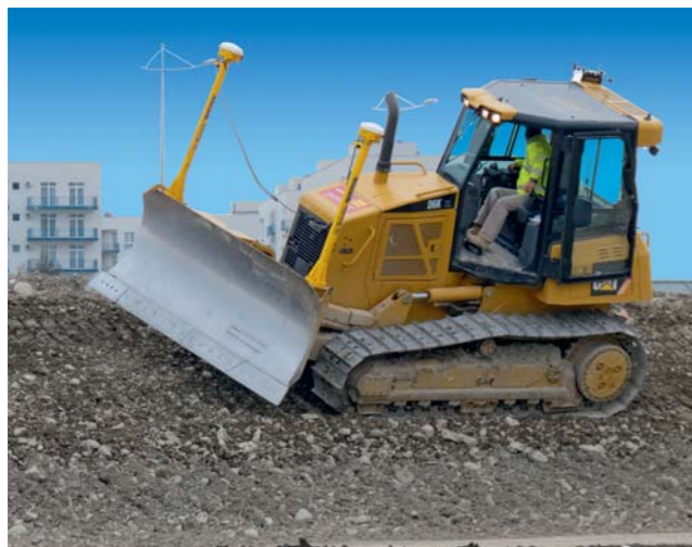
>>> Бульдозер Cat® D6K2 с 3D-системой Trimble dual GPS
